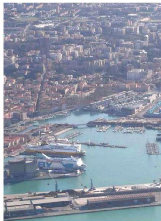
Una veduta dall'alto del porto di Livorno dove il processo di elettrificazione delle banchine è in una fase abbastanza avanzata
